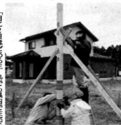
三隣亡の前年に仮柱を建てる 尾形ホーム（山形県鶴岡市）
